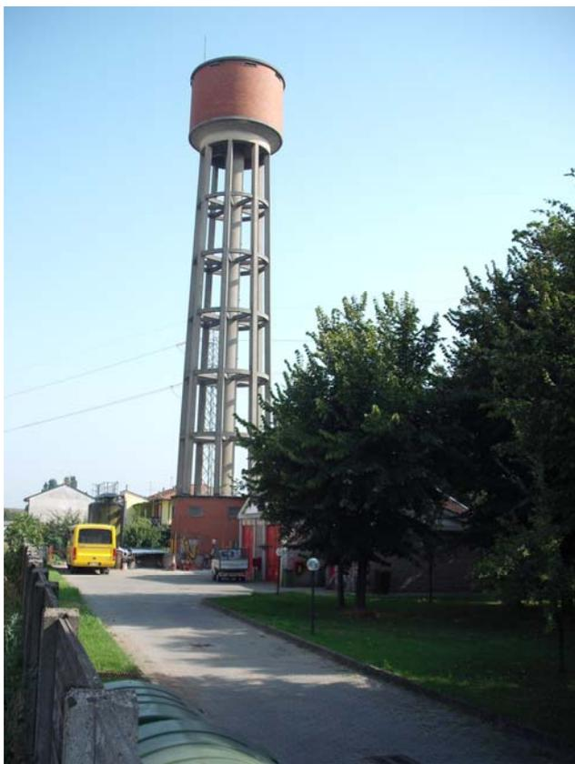
Figura 2.2: serbatoio di compenso rete acquedotto
